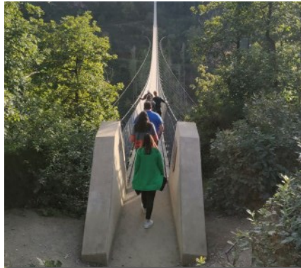
Geyerleih-Brücke im Hunsrück
