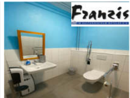
Behindertengerechte Toilette - Franzis
