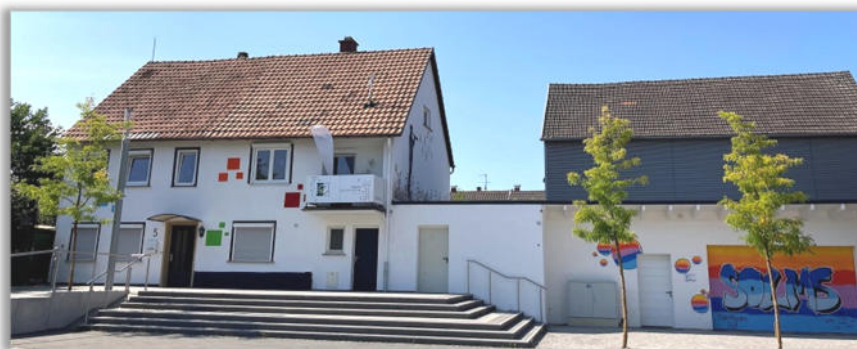
Neugestaltung des Bachtrompeters mit Hilfe von Wensert und Failing Design GBR
